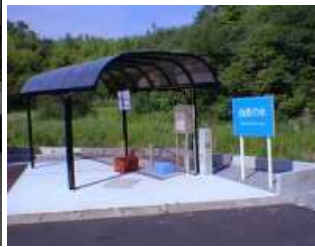
温泉スタンド 施工例
